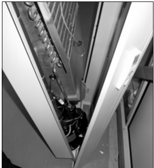
Imagen 8: Montaje del módulo clima en la puerta perfil
