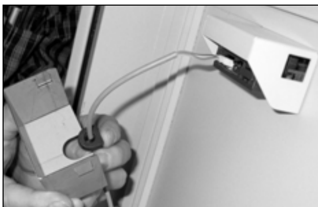
Imagen 16: Introducir la boquilla para cables
