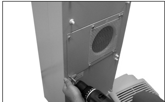
Imagen 63: Extraer los cuatro tornillos del ventilador del circuito exterior
