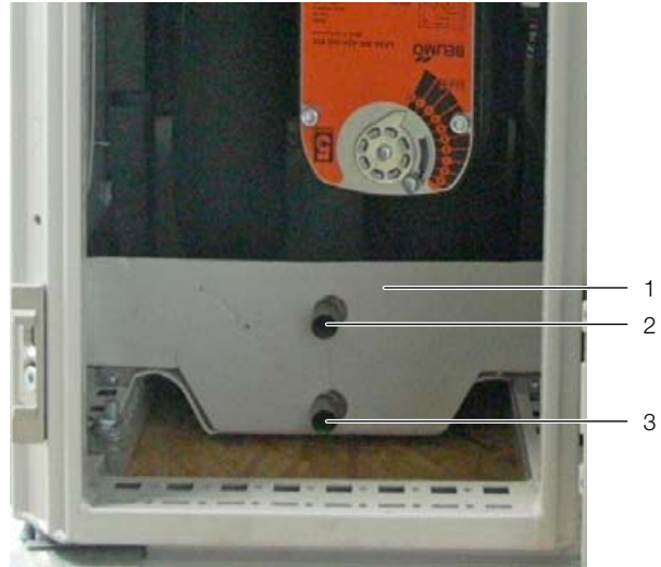
Fig. 73: Condensate discharge
