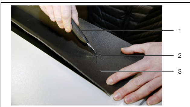
Fig. 6 : Réalisation du passage de câbles
