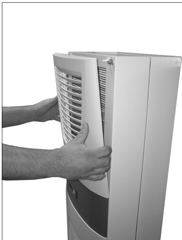
Fig. 42: Remove the upper louvred grille
