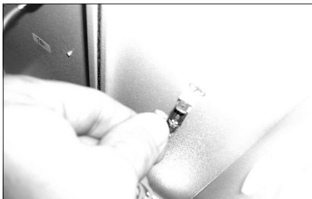
Imagen 76: Desconectar el cable de puesta a tierra del ventilador (2)
